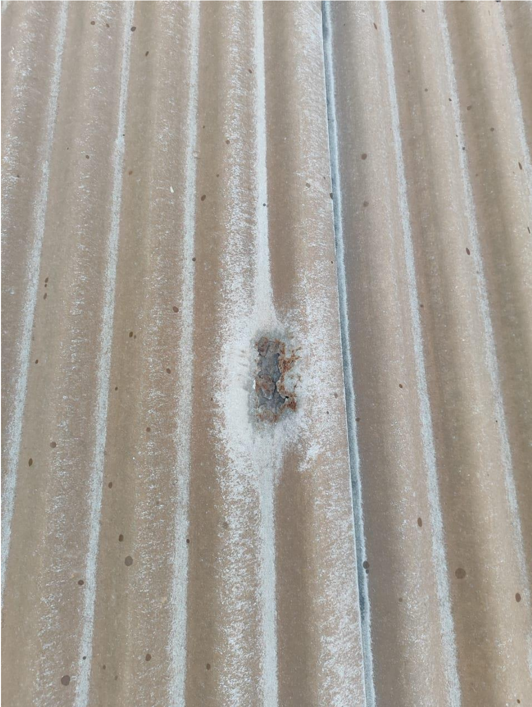
Telha danificada
